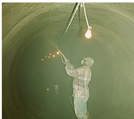
Aplicación por proyección de VANDEX BB 75
