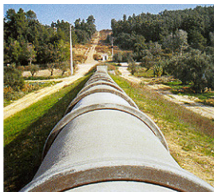
Conducto de agua potable Castelo do Bode, Portugal
