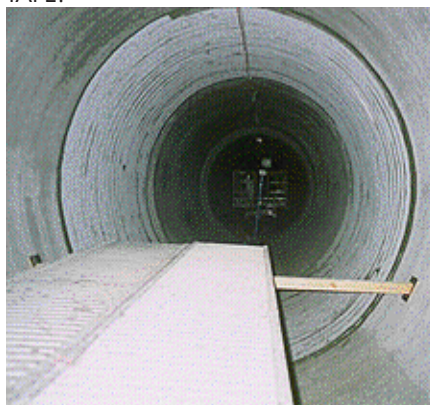
La sección del túnel muestra el tamaño de la circunferencia a tratar con VANDEX CONSTRUCTION JOINT TAPE.
