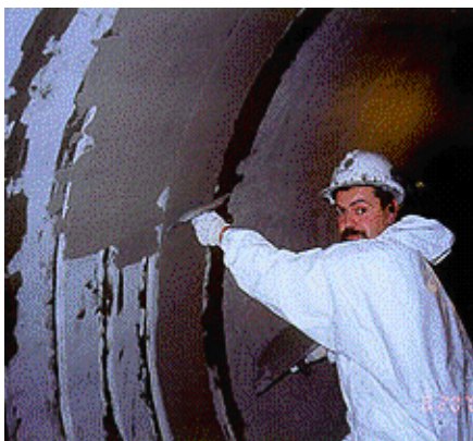
Cubrir VANDEX CONSTRUCTION JOINT TAPE con la segunda capa de VANDEX BB 75 E Z.
