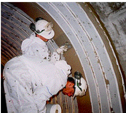
Asegurar una buena cohesión de VANDEX CONSTRUCTION JOINT TAPE y VANDEX BB 75 E Z.
