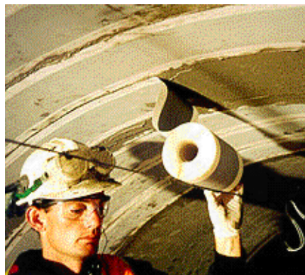
VANDEX CONSTRUCTION JOINT TAPE se aplica fácilmente en superficies de techos.
